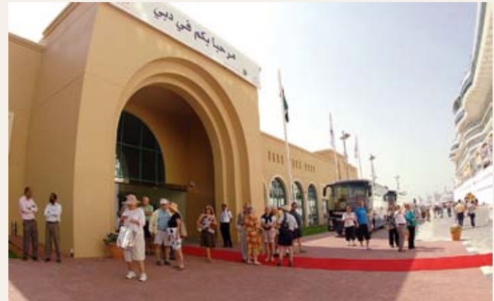
Das bereits 2010 eröffnete Terminalgebäude in Dubai
